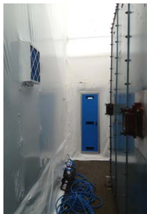
▲ Moyens de protection collective : confinement de la zone de travail.
